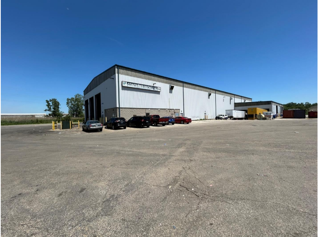
Fig 1.0 – Exterior Container MRF (SW- NE)
